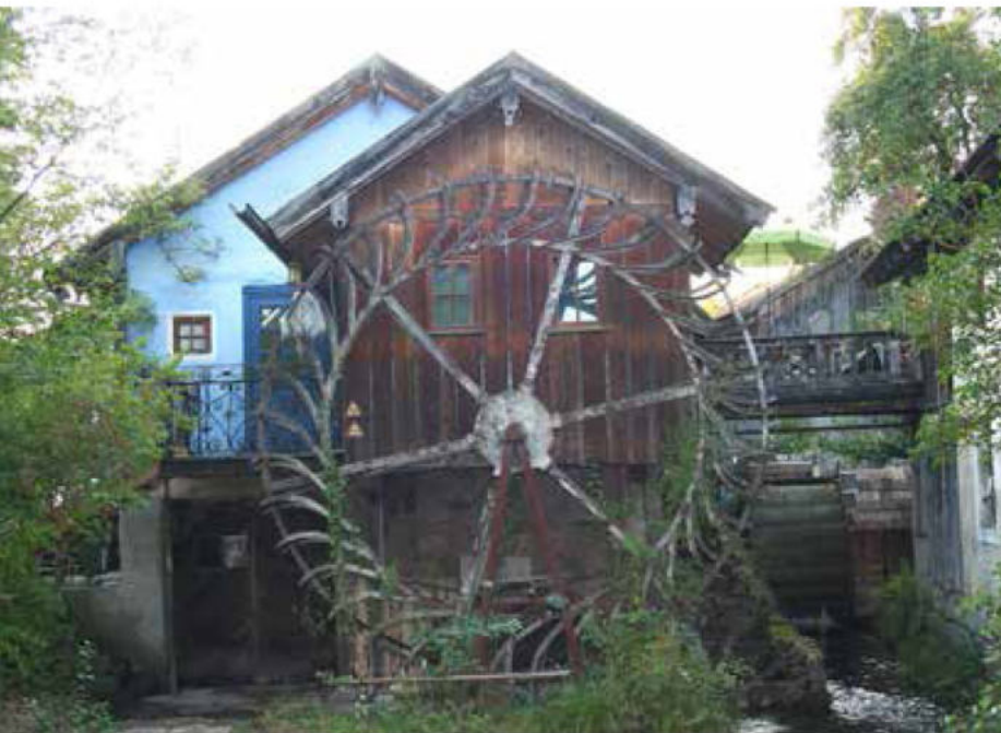
Zwei Wasserräder an der Heiligenmühle, 2015 Das alte mittelschlächlige vor der ehemaligen Säge zur Erinnerung – zwischen Haus und alter Säge das neue überschlächlige zur Stromerzeugung, gebaut aus einer 400 Jahre alten Burgmauer mit neuer Fischtreppe
