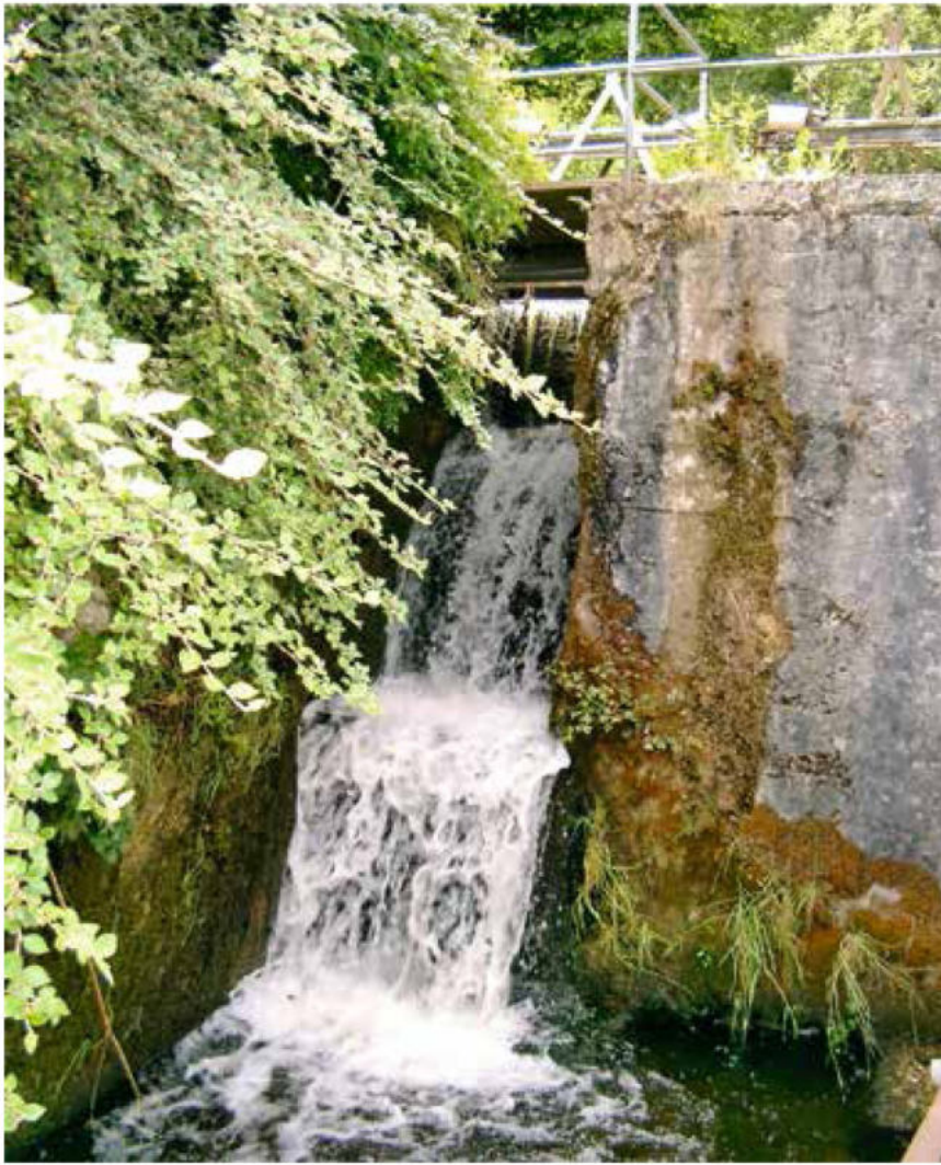
Standort der ehem. Jellmühle in Altenburg – heute das Moosacher Wasserwerk
