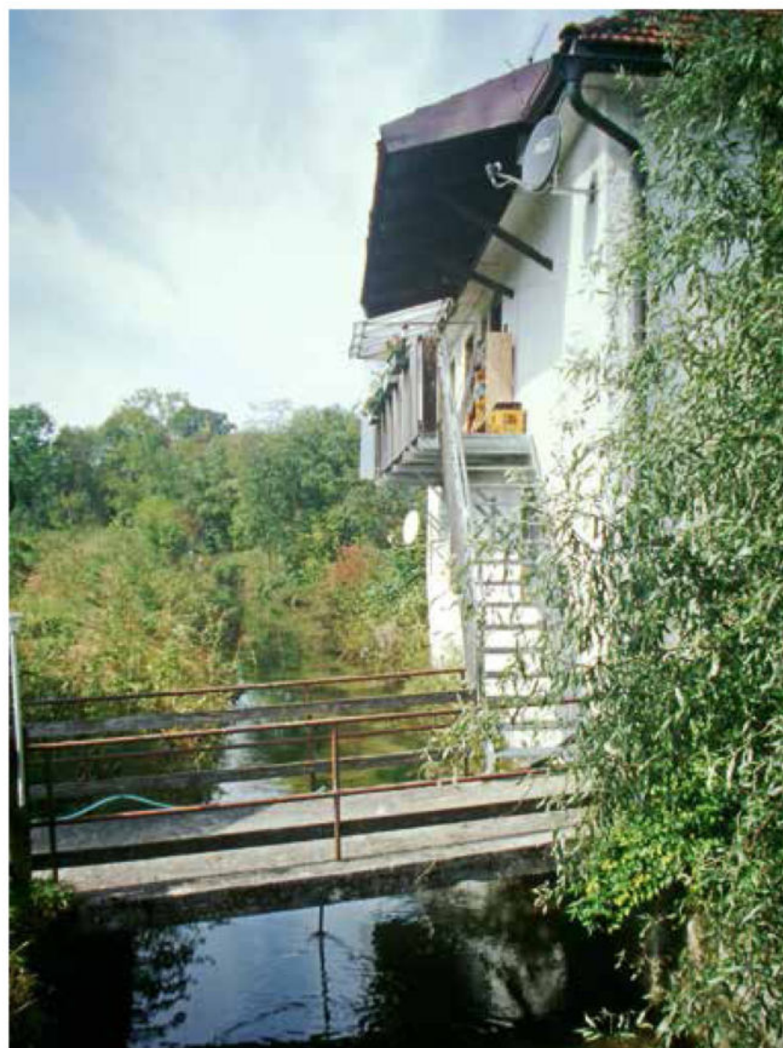
Heute wohnt wieder ein „Müller“ im Mühlenhaus der Sebaldmühle
