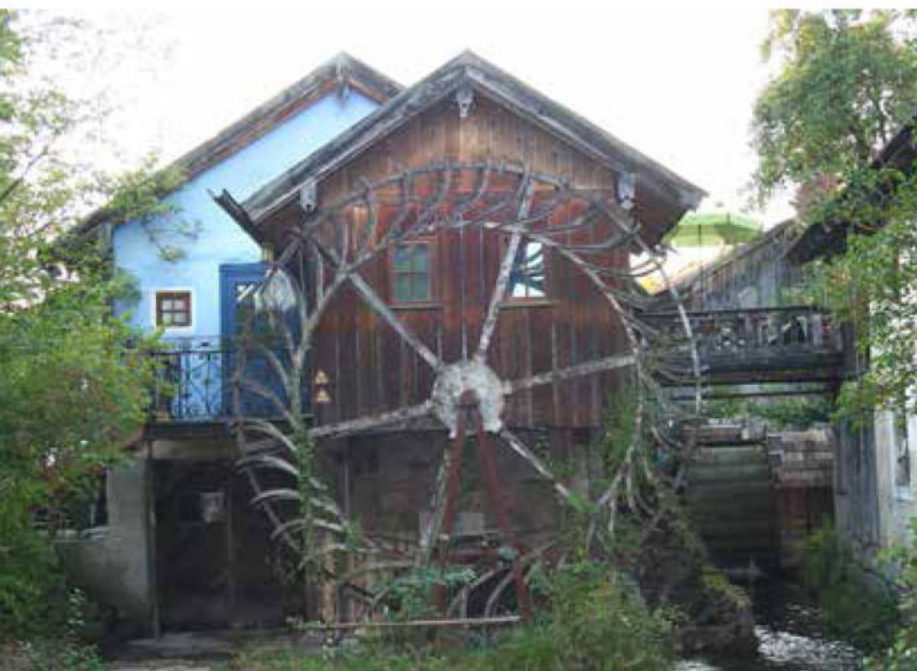
Zwei Wasserräder an der Heiligenmühle, 2015 Das alte mittelschlächtige vor der ehemaligen Säge zur Erinnerung – zwischen Haus und alter Säge das neue überschlächtige zur Stromerzeugung, gebaut aus einer 400 Jahre alten Burgmauer mit neuer Fischtreppe
