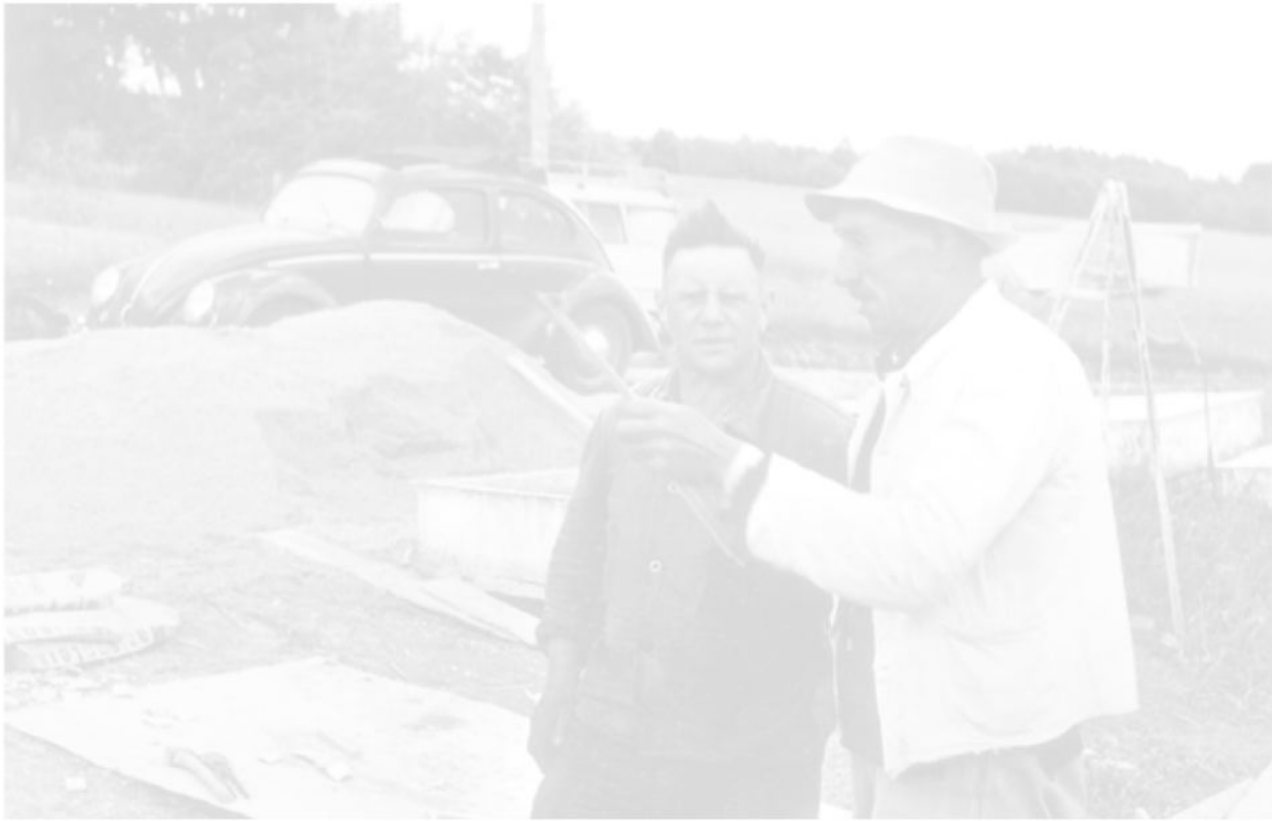
Balthasar (Hausl) Simmer beim Hausbau der Familie Schäfer, Falkenberg 1955
