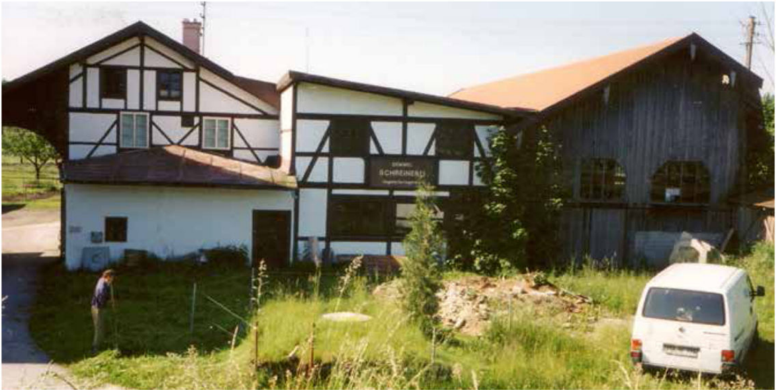
Früher Werkstattgebäude der Firma Demmel – seit 1992 Atelier und Wohnung der Familie Maier-Ott
